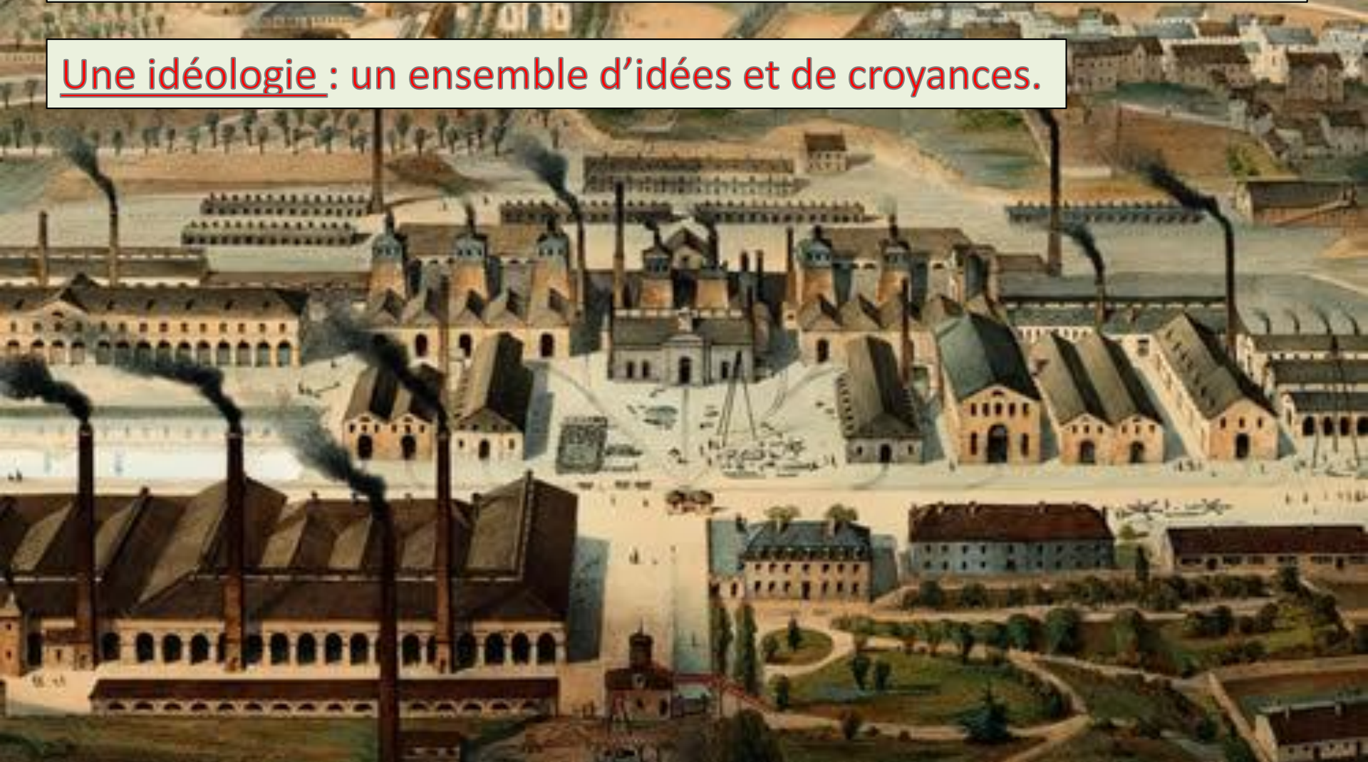
Le Creusot, vue prise du nord en 1847, Trémaux
