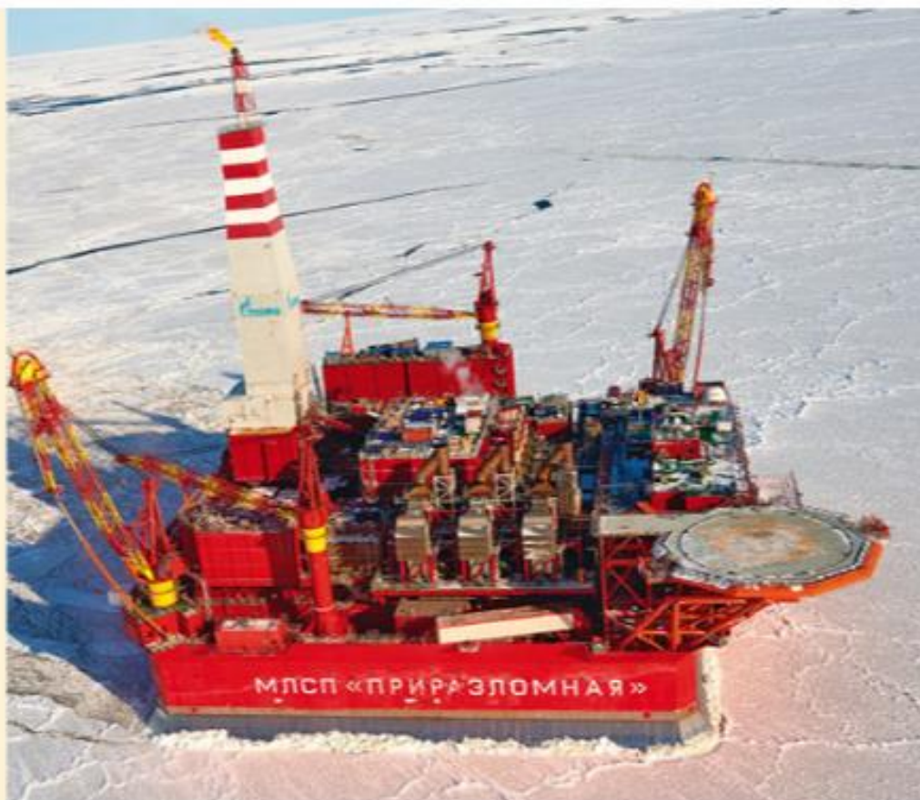
Plateforme offshore de Pirazlomnaya, 2015.
